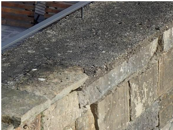
Betonschlag als Mauerabdeckung
