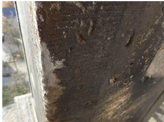
Zustand im Detail
