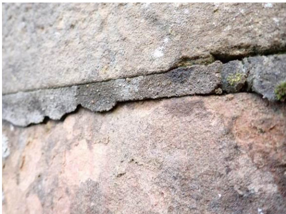
Weitere gelöste Fugenreparatur
