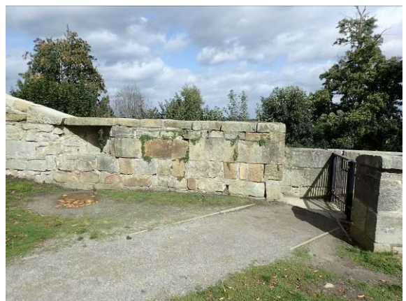
Wasserführung zur Wehrmauer
