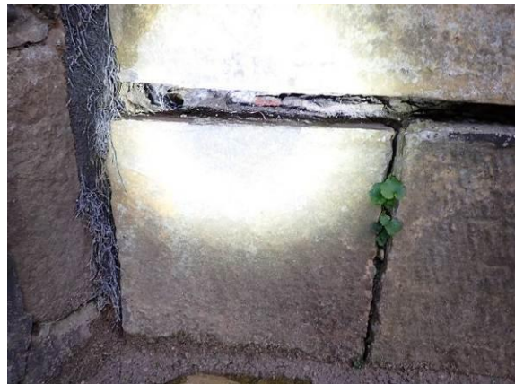
Zustand im Detail
