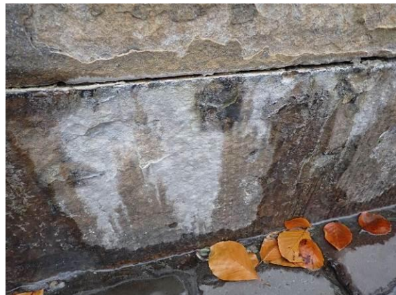
Bindemittelauswaschung im Detail
