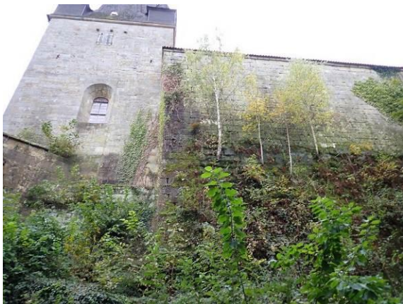
Sockelbereich an der Katharinenkirche
