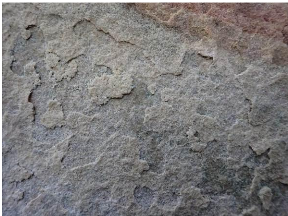
Bindemittelauswaschungen im Detail
