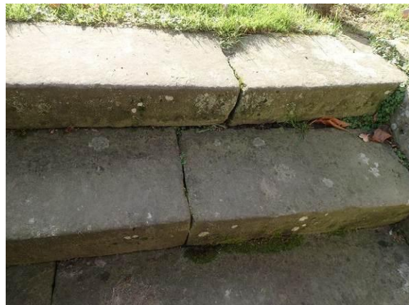
Verformte Blockstufen
