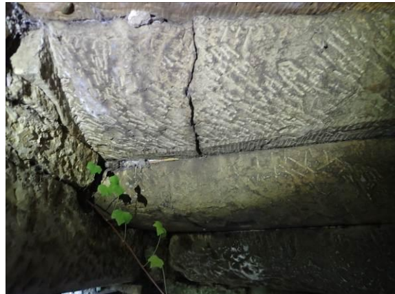
Gebrochene Blockstufe
