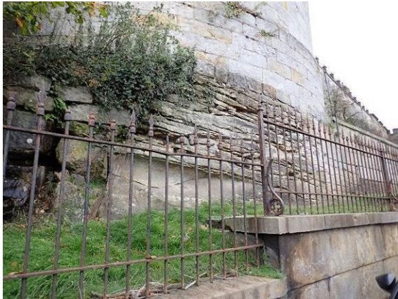
Teilbereich der Zaunanlage, Südterrasse
