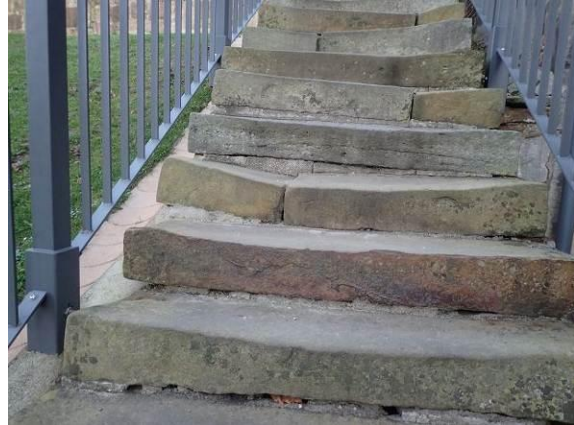
Verformter Stufenbelag
