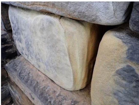
Bindemittelverlust durch Ausschwemmung
