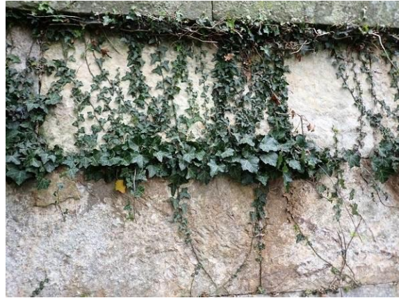
Zustand im Detail
