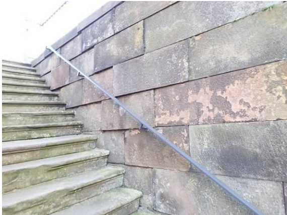
Teilbereich der südliche Wangenwand
