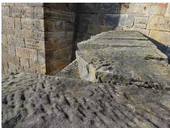
Geschädigte Abdeckplatten
