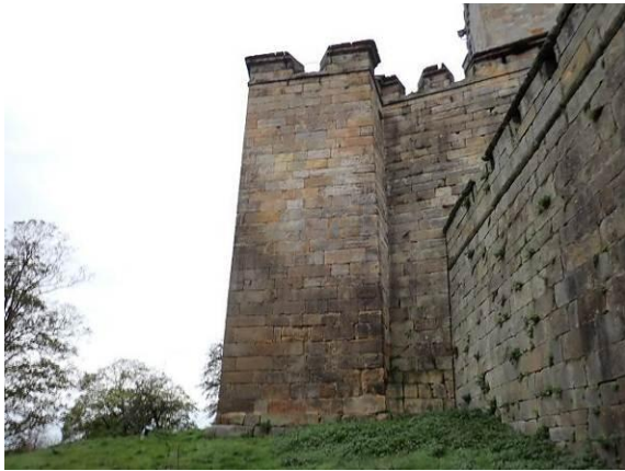
Teilansicht Eckverstärkung Südost
