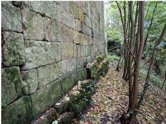
Sockel an der Nordwand
