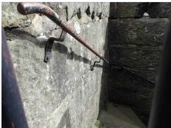
Geländer der Treppe zur nordöstlichen Ausfallpforte
