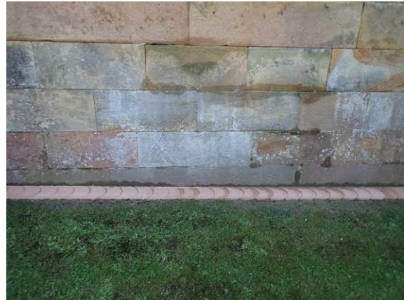
Durchsickerndes Schichtenwasser, Südostterrasse
