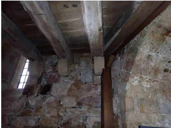
Innenoberfläche Südwestecke Katharinenkirche
