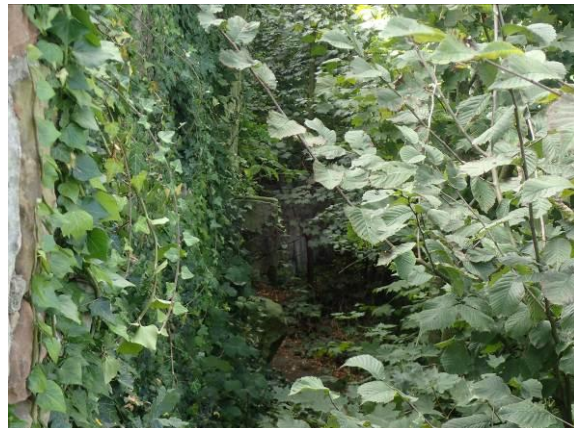
Zustand im Detail
