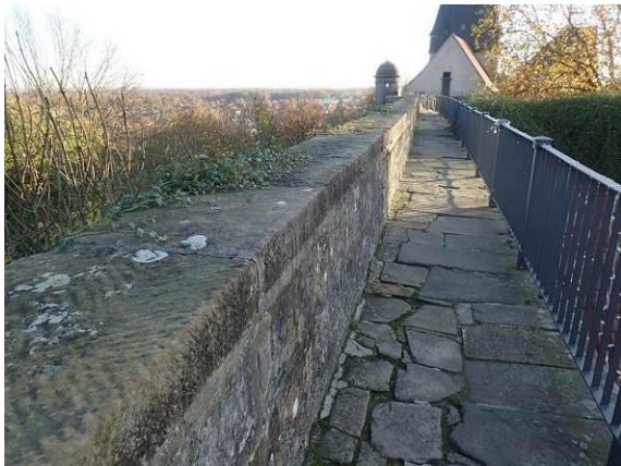
Teilbereich des Nordwehrgangs
