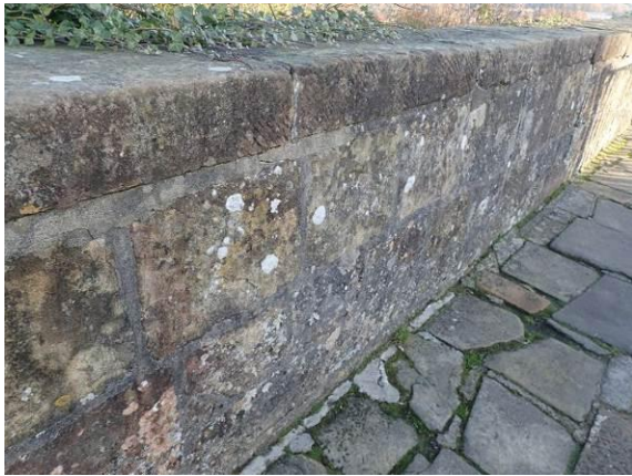
Attika der nördlichen Wehrmauer
