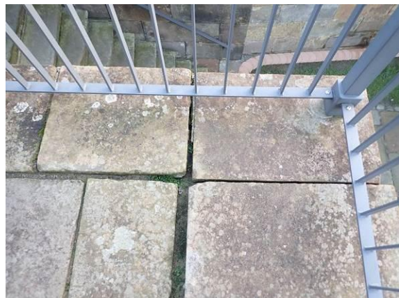
Zustand im Detail
