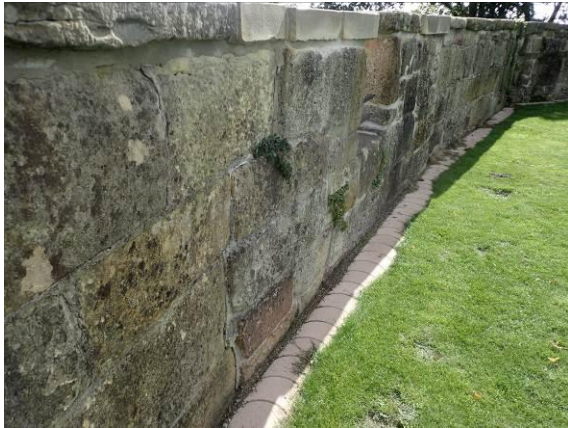
Verformung Mauerkrone
