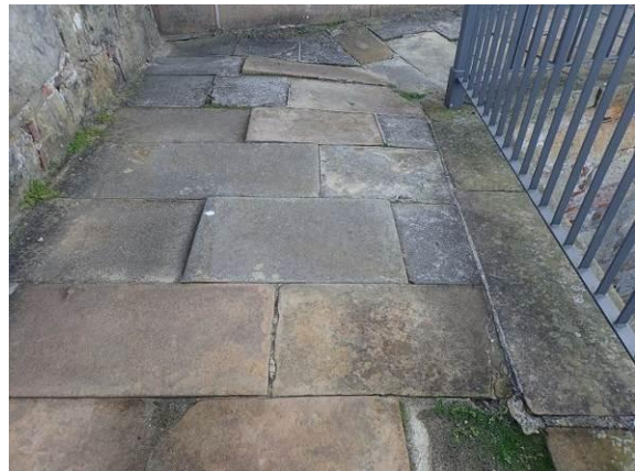
Verformter Bodenbelag
