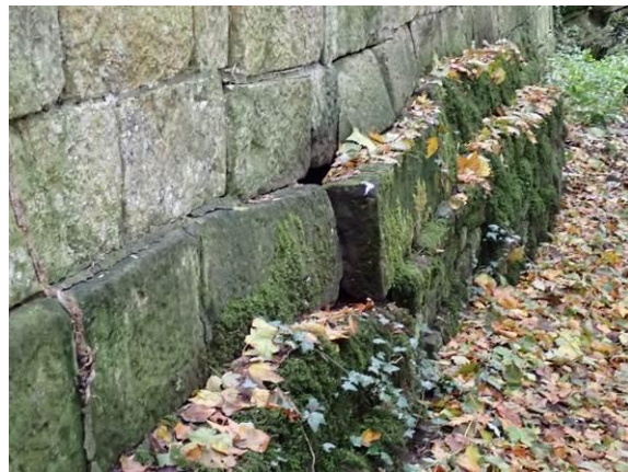
Zustand im Detail
