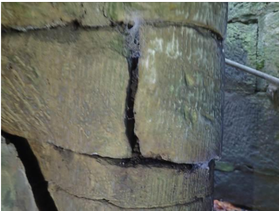
Blockstufenbruch im Spindelbereich
