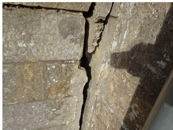
Abriss Ost vom Pulverturm
