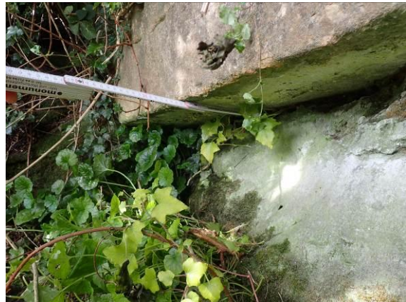
Aufstand der äußeren Schale auf dem Felsen
