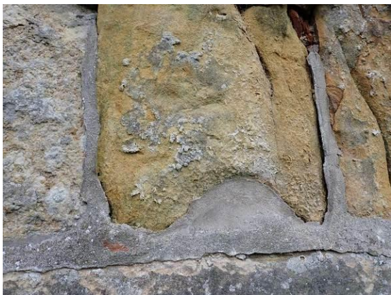
Zementöse Reparaturverfugung
