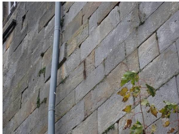
Verschobenen Quader im Detail
