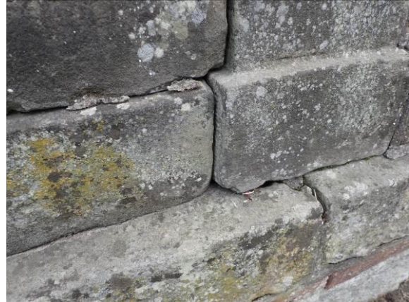
Zustand im Detail
