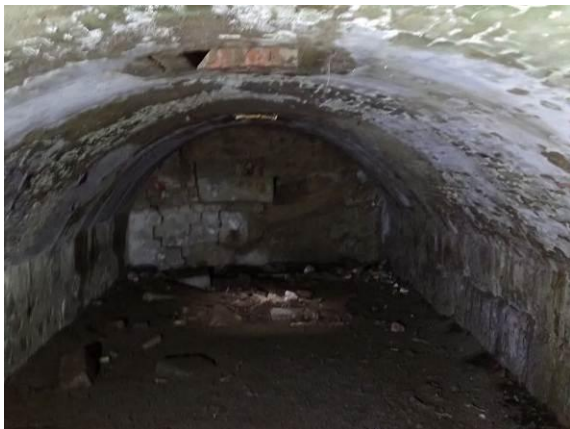
Untersicht Gewölbe des Schafstalls
