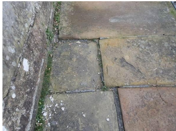
Verformter Bodenbelag
