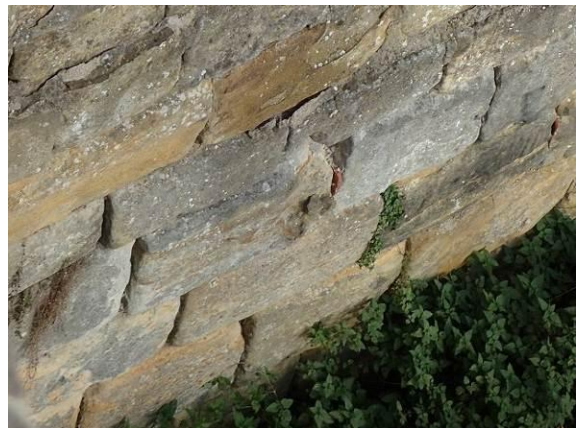
Verstärkte Steinschädigung
