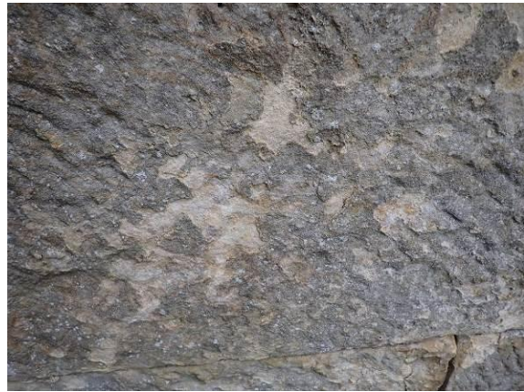
Krustenabsprengung im Detail
