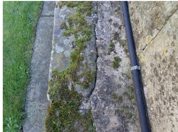
Schalenablösung im Detail
