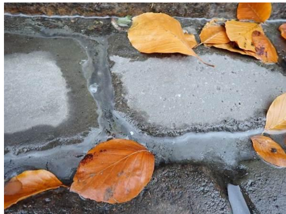
Bindemittelanreicherung im Wasser
