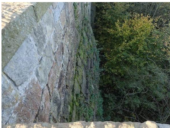
Strebemauerwerk
