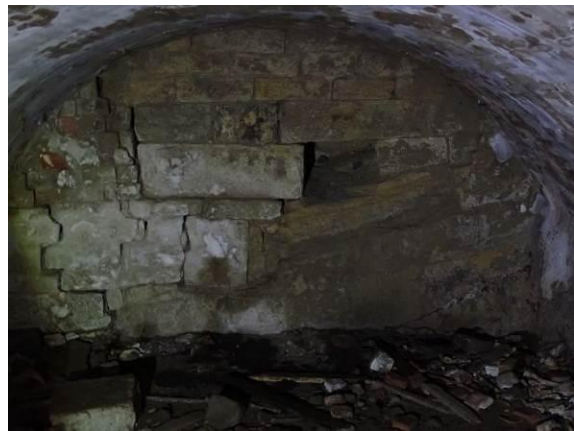
Östliche Wangenwand im Schafstall
