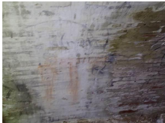
Kalksinterkruste im Detail
