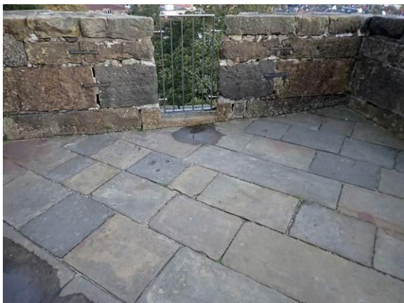
Verfugung Terrassenbelag Südost
