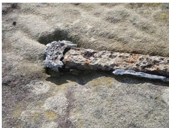
Geschädigte Verklammerung
