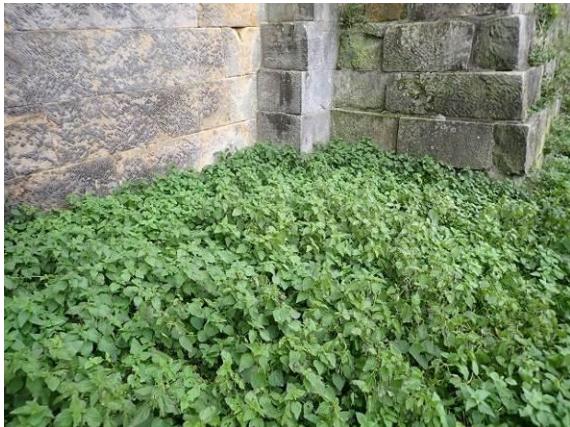
Fundamentmauerwerk am Wandaufstand
