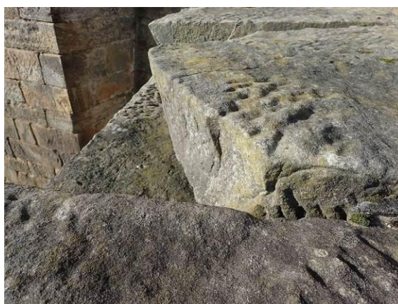
Geschädigte Abdeckplatte
