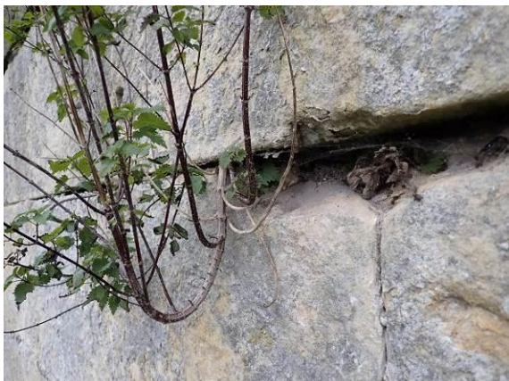
Detail, Kantenausbrüche
