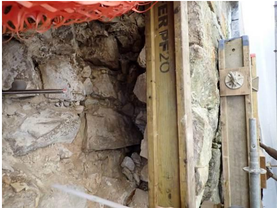
Gesicherte Schalenablösung
