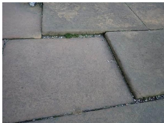
Zustand im Detail
