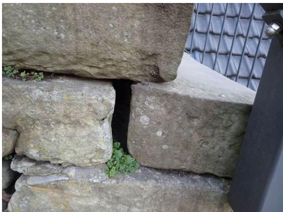
Verschobene Blockstufen
