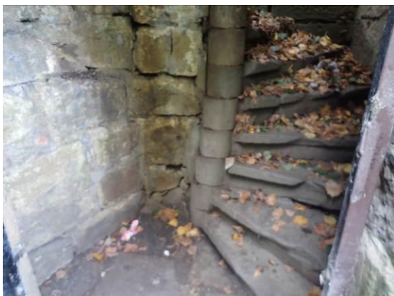
Verformte Spindel
