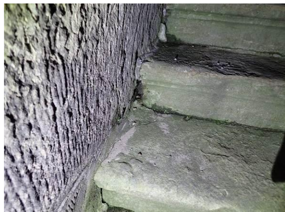
Seitlicher Anschluss zur Wangenwand
