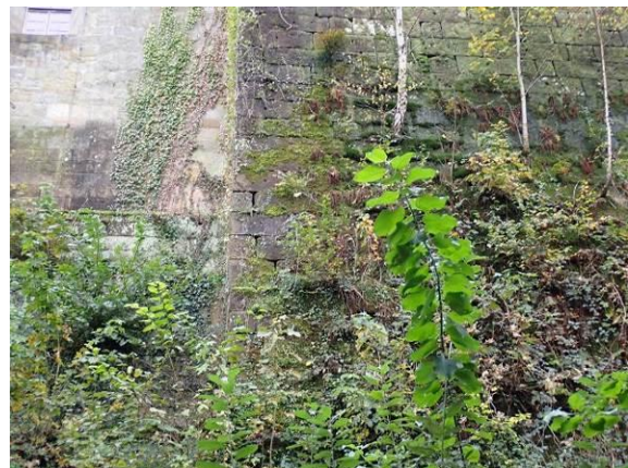
Zustand im Detail
