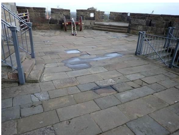
Verformung Bodenbelag
