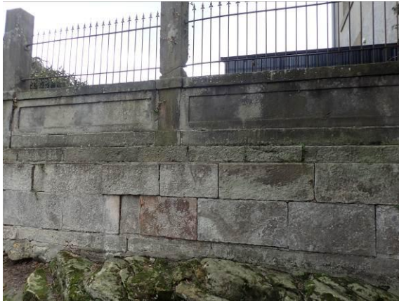
Verformung Sockelmauerwerk
