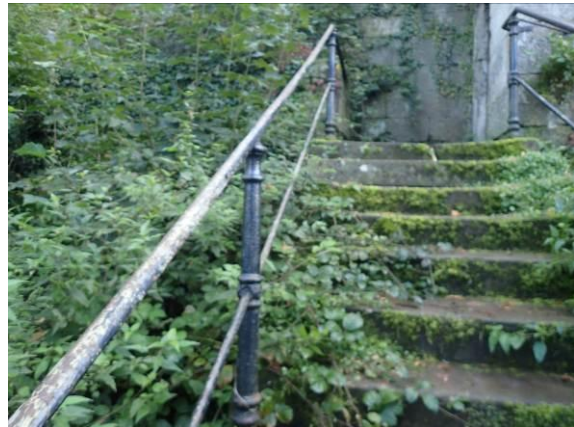
Zustand im Detail
