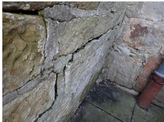
Zustand im Detail
