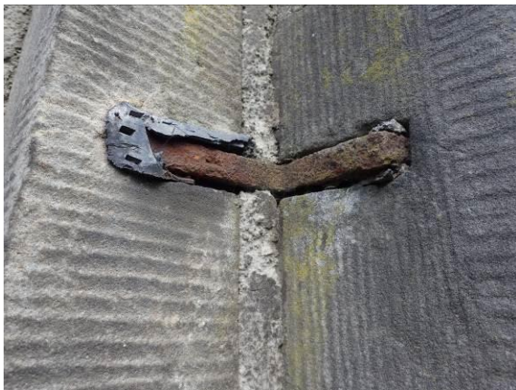
Geschädigte Verklammerung
