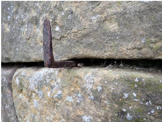
Korrodiertes Halteisen
