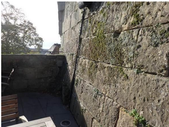
Anschluss untere Wehrmauer
