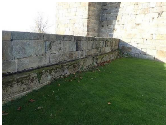
Attika der Südwand
