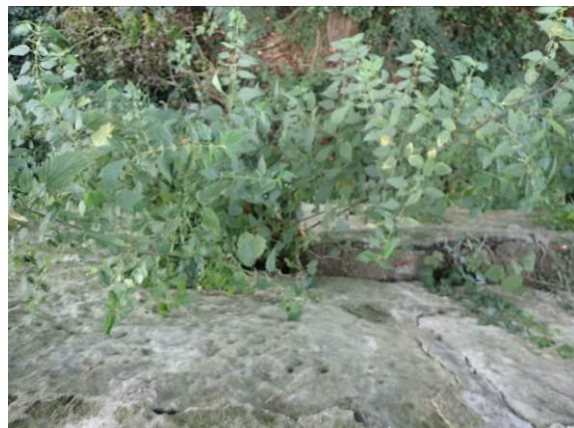
Verformung am Stützwandanschluss
