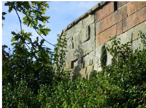
Anschluss eines Reparaturbereichs
