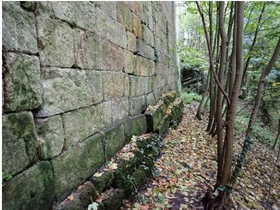
Zustand im Sockelbereich
