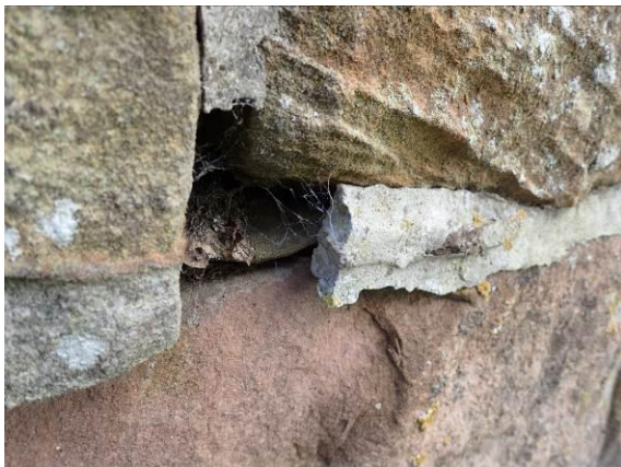
Überfugter Gefügeschaden
