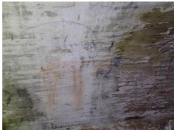
Kalksinterkrustenbildung auf der Unterseite
