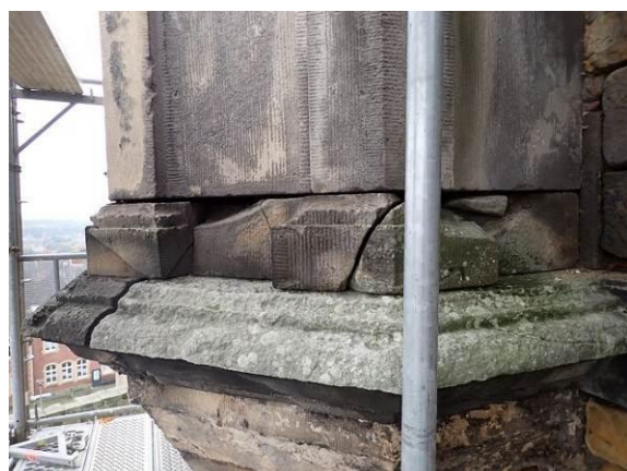
Geschädigter Basisring
