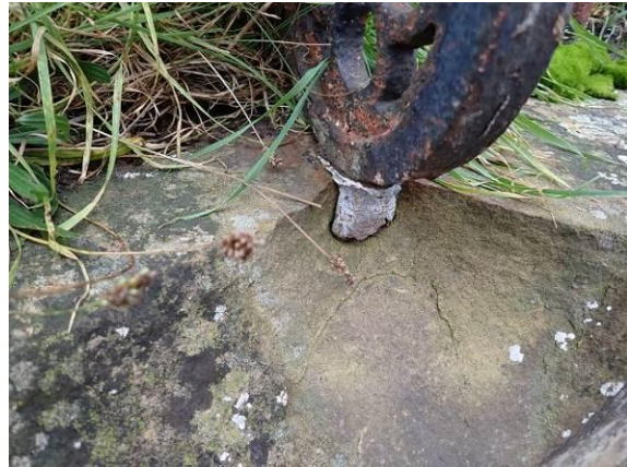
Gelöste Verbindung zum Sockel
