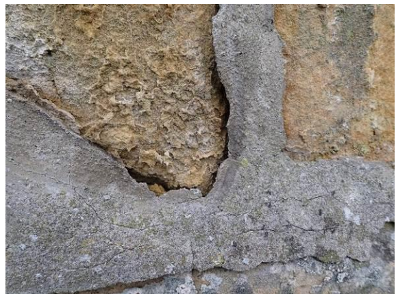
Zustand im Detail
