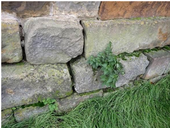
Schädigung Fundamentmauerwerk
