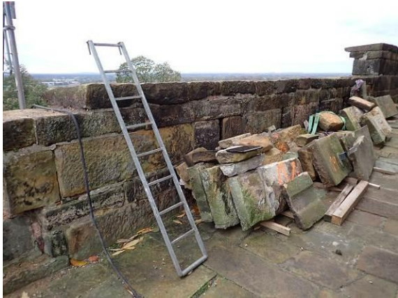
Teilbereich der östlichen Wehrmauer
