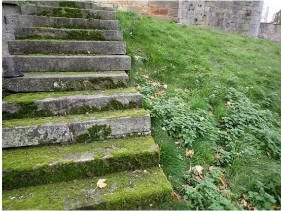
Östliche Freitreppe zu den Südterrassen
