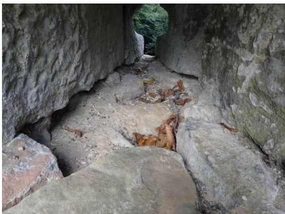
Zustand im Kernmauerwerk
