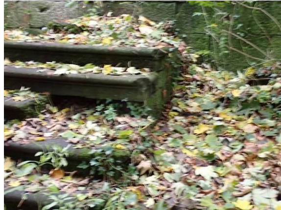
Zustand im Detail
