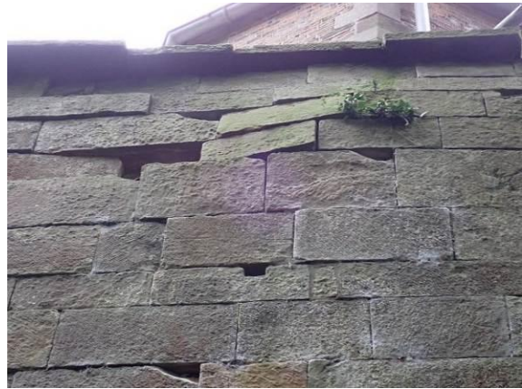
Zustand im Detail
