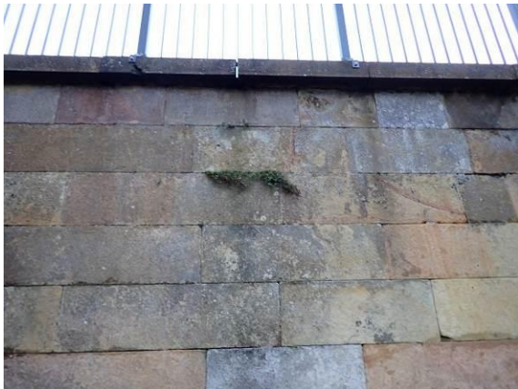
Teilbereich der oberen Nordterrassenwand
