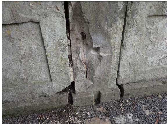
Geschädigter Fundamentanschluss
