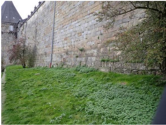
Teilansicht südliche Wehrmauer
