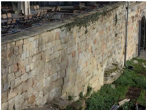
Verformung Mauerschale
