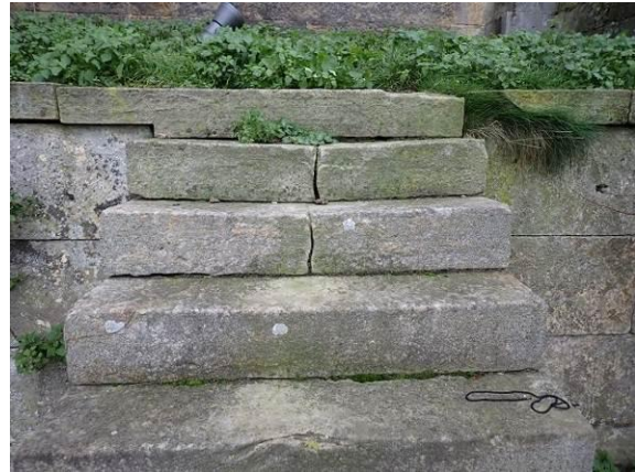
Gebrochene Blockstufen im oberen Lauf
