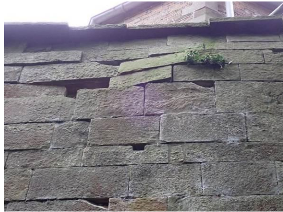
Zustand im Detail
