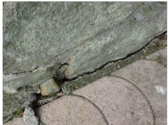
Abriss von den neu verlegten Kantensteinen
