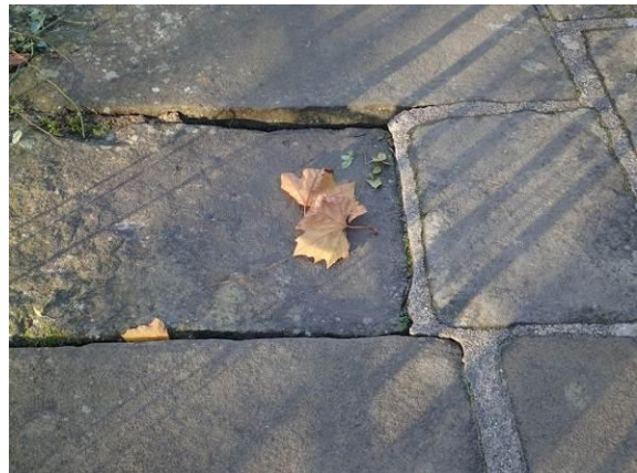
Versackte Bodenplatten
