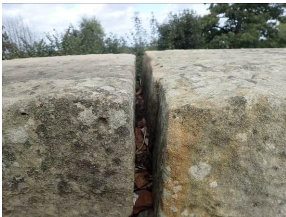
Geschädigte Verfugung
