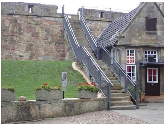
Treppe zur nördlichen oberen Wehrmauer
