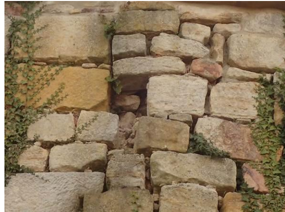
Zustand im Detail
