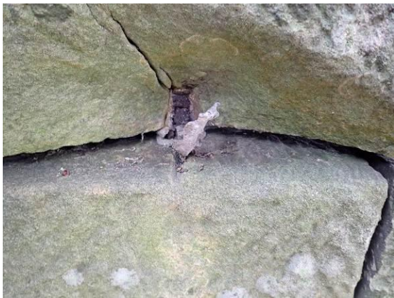
Korrosionssprengung eines Dornes
