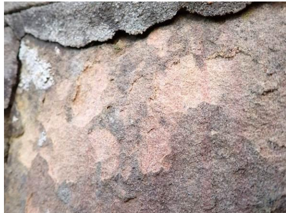
Abgelöste Zementfuge
