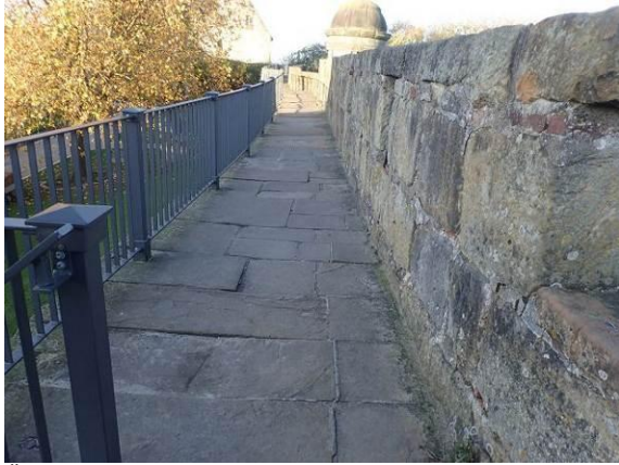
Östlicher Bereich des Wehrgangs
