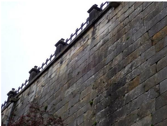
Teilansicht oberer Wandbereich
