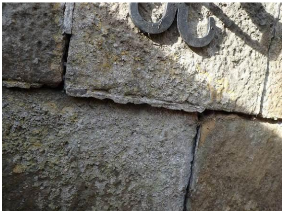
Verformtes Wangenmauerwerk
