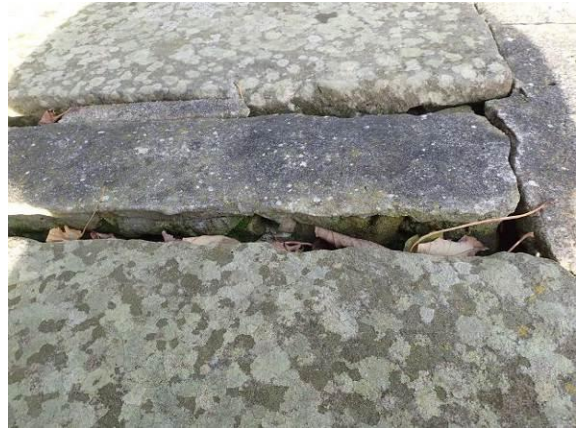
Zustand im Detail
