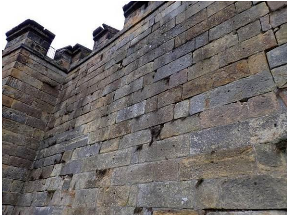
Teilbereich der oberen Ostmauer
